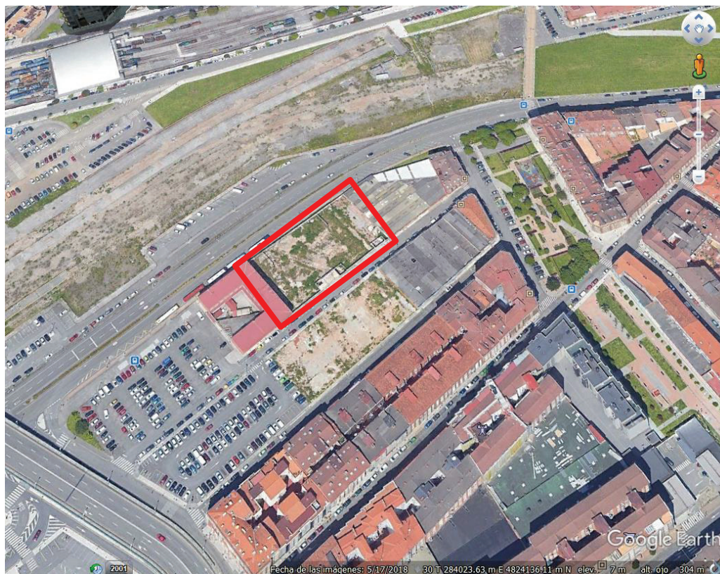
Figura 2. Vista aérea de las instalaciones (2018).
