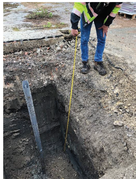
Calicata tras extracción de tierras (11/04/19)
